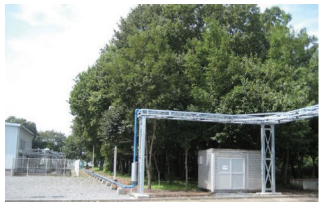
排水管を地上化
