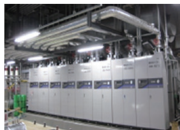
ガス焼き貫流ボイラー
