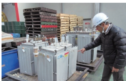
廃棄物処理の現地確認
